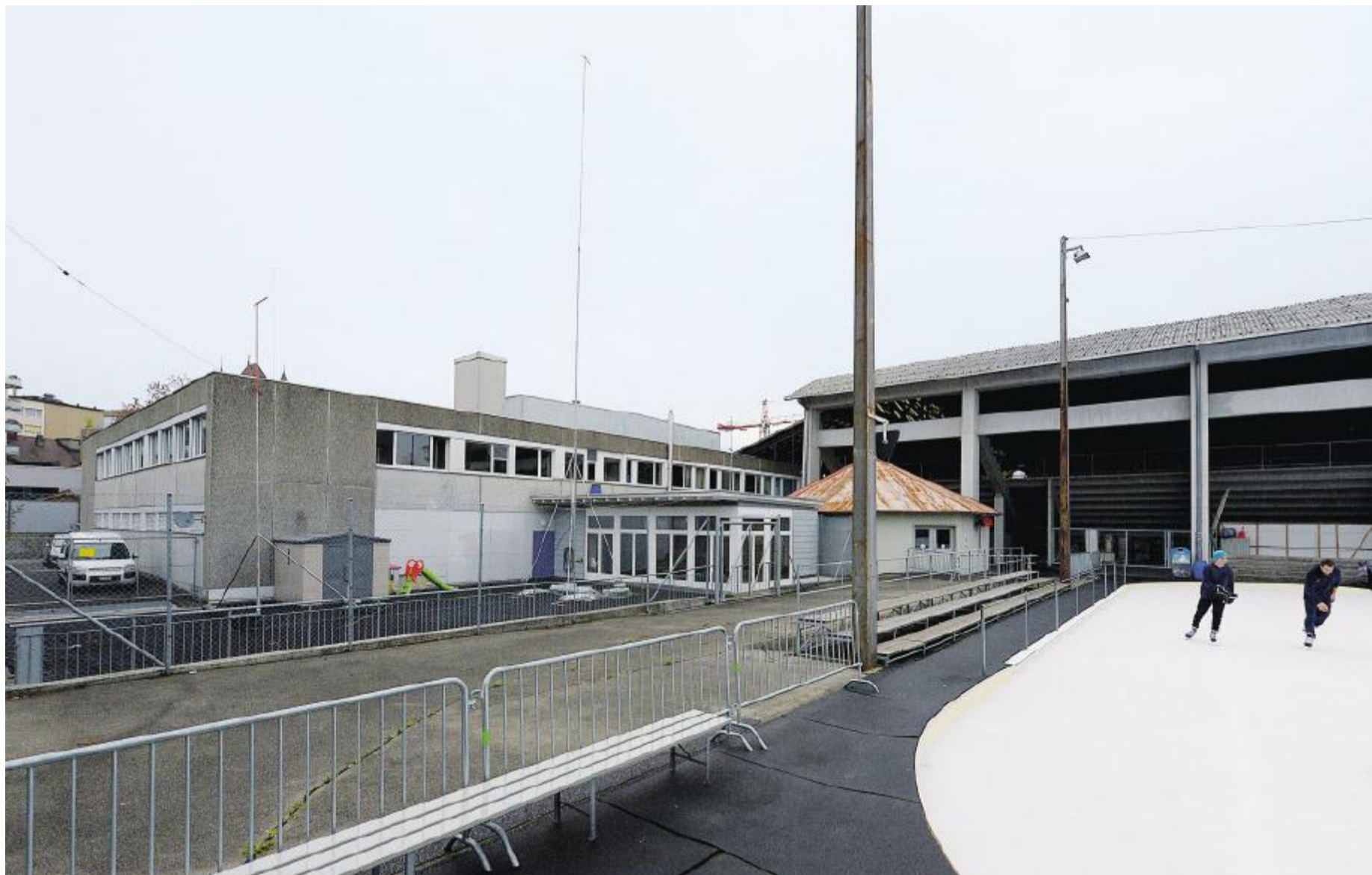
Die Profile für den Predigtsaal im Grabengut stehen wieder: Mit rund zweijähriger Verzögerung ist das Baugesuch der Freikirche Bewegungplus publiziert.
